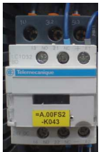
(Fig.3.3-3) Contactor de Potencia.
