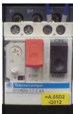
(Fig.3.3-2) Protección térmica.
